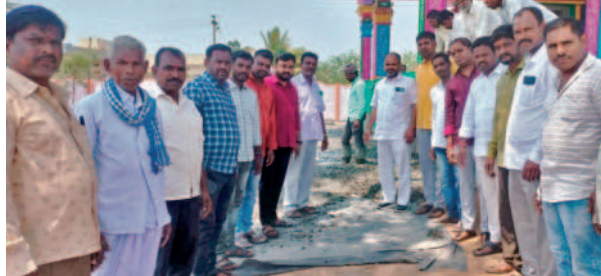
పిసి రోడ్డు నిర్మాణ పనులను పరిశీలిస్తున్న నాయిని యాదగిరి
